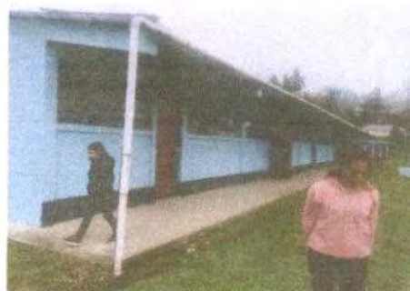
Foto 4: SUSTITUCION DE CANAL PVC
