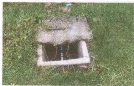
Foto 8: SUSTITUCION DE CAJA DE REGISTRO
