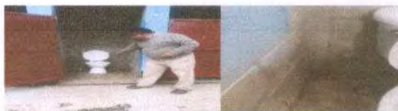
Foto 6: SUSTITUCION DE INODORO
