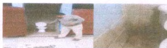
Foto 6: SUSTITUCION DE INODORO
