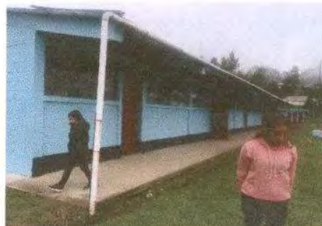
Foto 4: SUSTITUCION DE CANAL PVC
