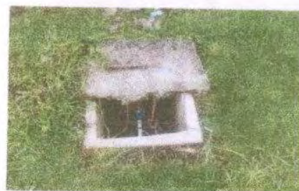
Foto 8: SUSTITUCION DE CAJA DE REGISTRO
