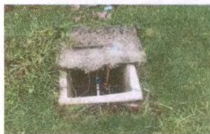
Foto 8: SUSTITUCION DE CAJA DE REGISTRO
