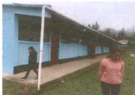
Foto 4: SUSTITUCION DE CANAL PVC
