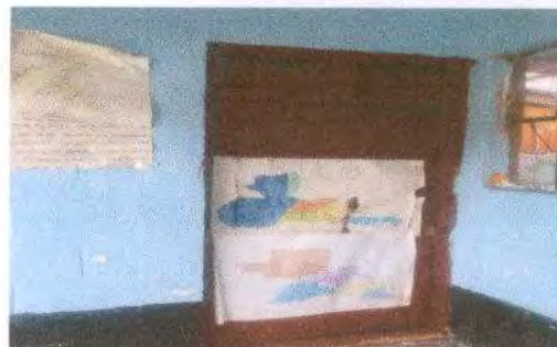
Foto 2: SUSTITUCION DE PUERTA DE MADERA POR METAL
