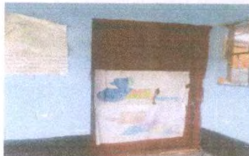
Foto 2: SUSTITUCION DE PUERTA DE MADERA POR METAL
